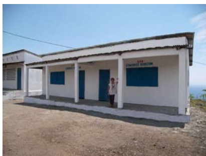
La nouvelle école
